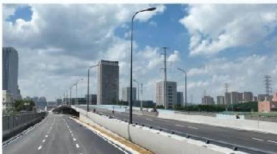
6月1日，由建投集团所属城投公司代建的宿松路（南二环-深圳路）快速化改造工程2标段上跨花园大道跨线桥正式建成通车。自2021年11月22日首根桩开钻以来，仅历时188天即实现通车，较计划工期提前80天。本次放行通车的花园大道跨线桥桥梁全长420m、标准段宽25.6m,设计时速80km/h。
